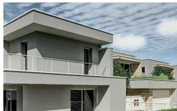
B1 - f _ Balconi con parapetti c.a. e ferro verniciato
